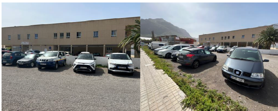
Vista del Centro de Salud de La Aldea de San Nicolás, dotación sanitaria consolidada colindante al límite sur de la parcela objeto de la modificación. Fuente: elaboración propia.
