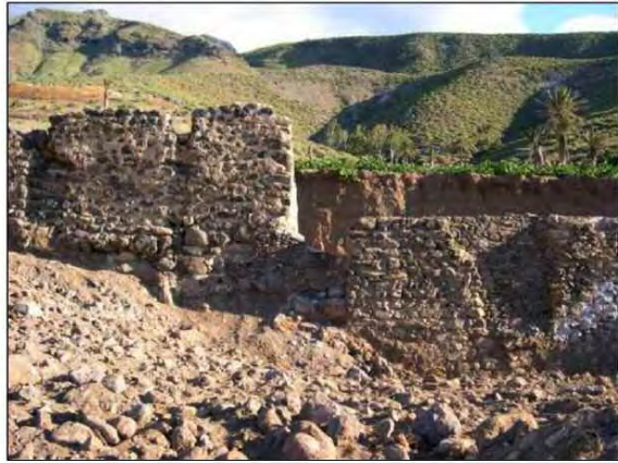
Cimentación de mampostería del acueducto de madera y base del cubo del molino
