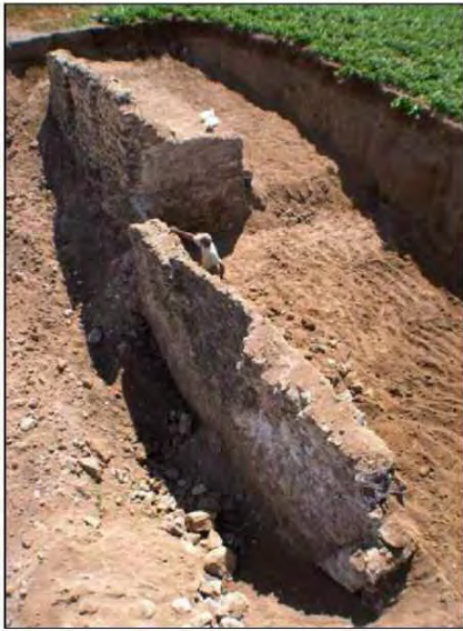
Cimentación de mampostería del acueducto de madera y base del cubo del molino
