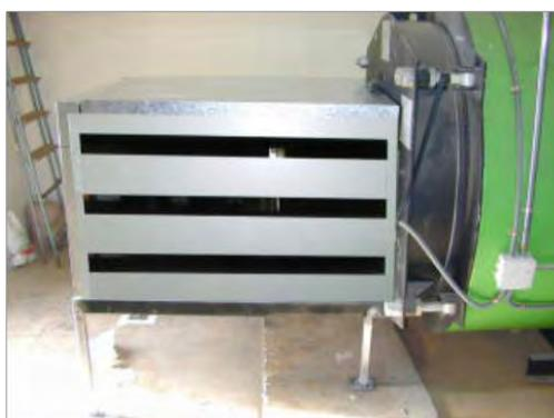
**Fig 3. Quemador con encapsulado**
