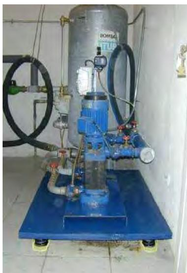
Fig 3. Ejemplo bancada inercia
