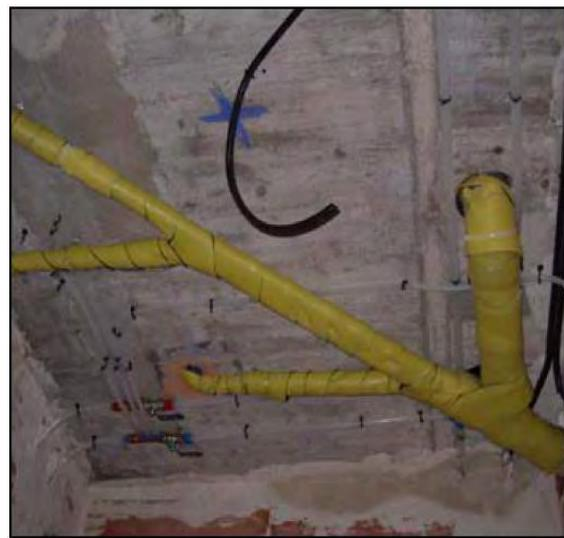
Fig 2. Aislamiento de pulpo de desagüe
