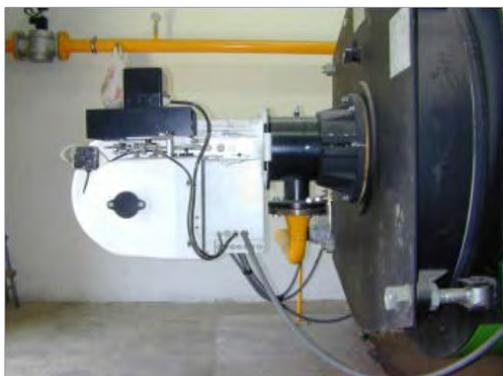
**Fig 2. Quemador sin encapsulado**
