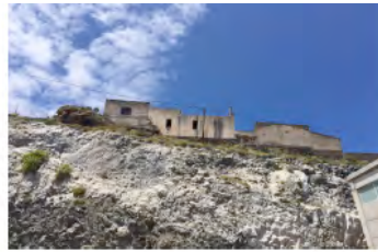
Vista del desnivel completo
