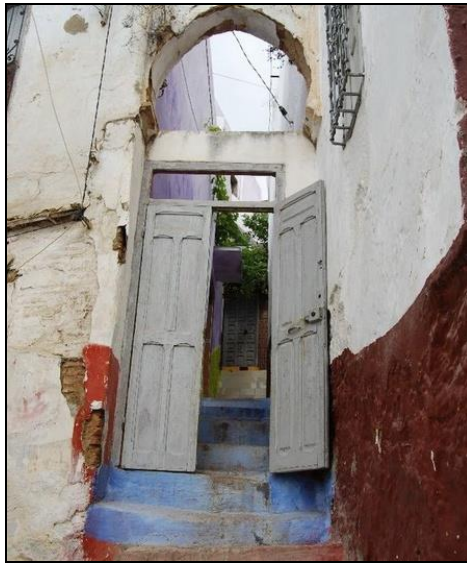
Ilustración 14. Vista de revestimiento exterior. 36
