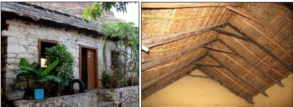
Ilustración 3. Fachada de vivienda tradicional e interior de la techumbre 9 .
