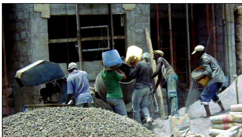
Ilustración 8. Operarios trabajando en la construcción de una vivienda.
