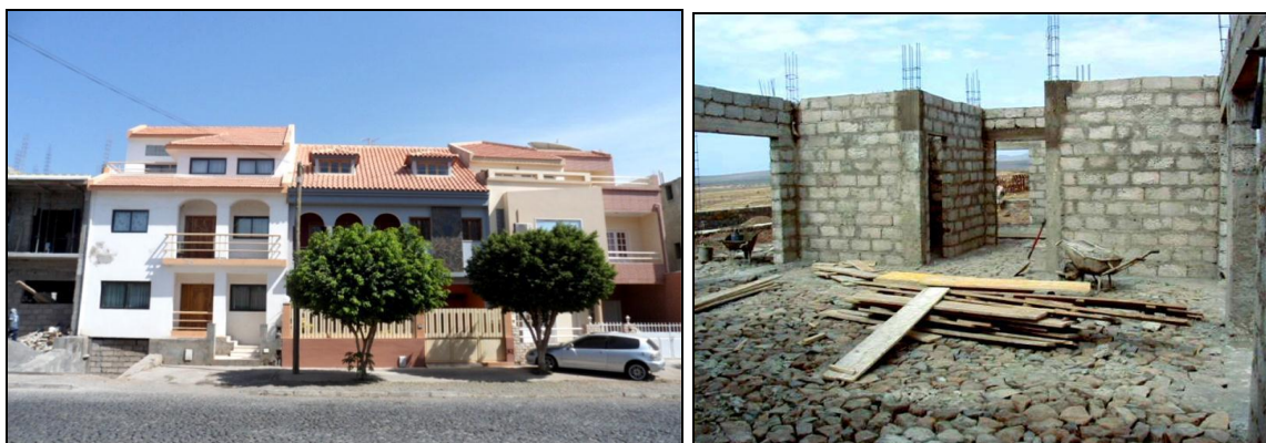
Ilustración 7. De izquierda a derecha: fachada de vivienda tipo dúplex e interior en construcción, respectivamente.
