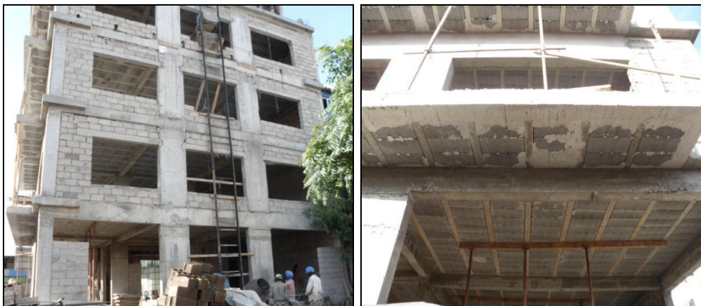
Ilustración 10. Edificio de oficinas en construcción con forjados de losa aligerada en Cabo Verde.
