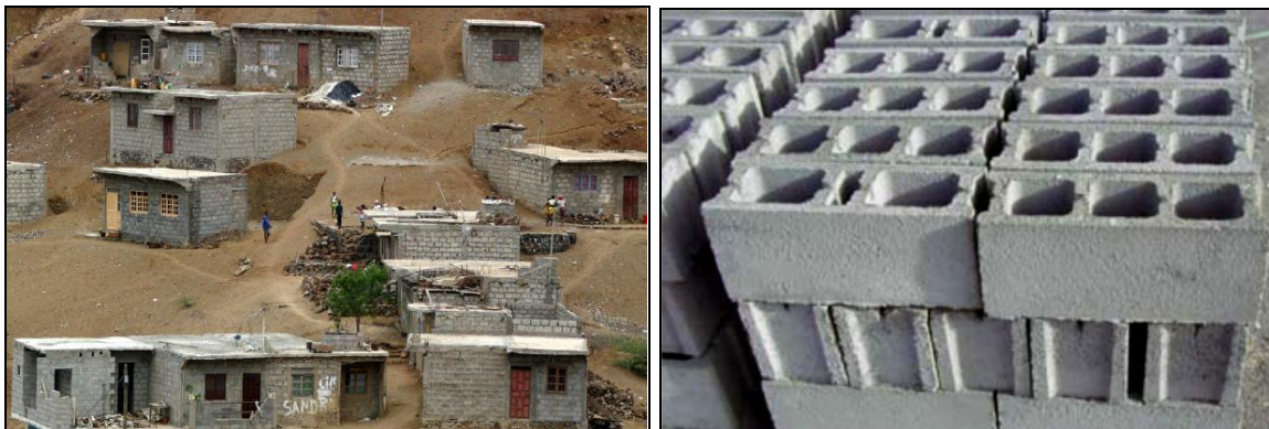
Ilustración 6. De izquierda a derecha: vista de edificaciones de bloque de hormigón y bloques acopiados, respectivamente.
