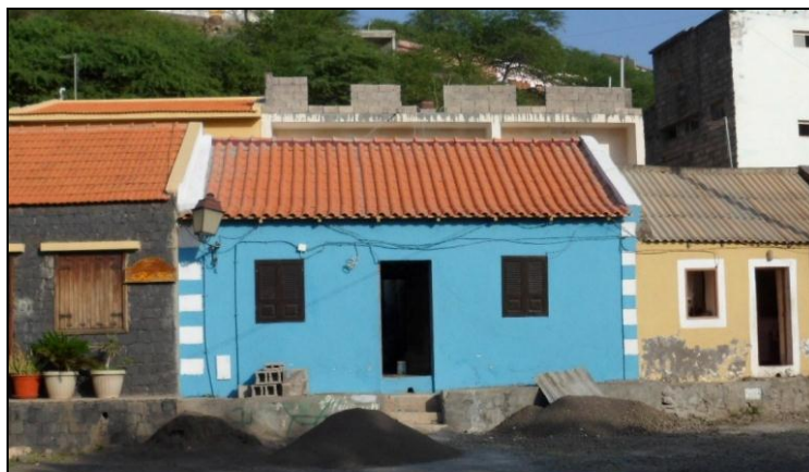
Ilustración 4. Fachada de vivienda tradicional con tejado renovado.
